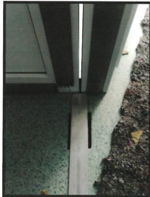
11. Buscar una solución en la vibración de los pisos en contenedores que están adosados entre ellos./ Problems regarding excessive vibration in joint containers, specially the ones that are elevated to save the 12 cm difference due to the 1% slope.
